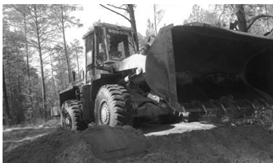
Рис. 5. Уплотнение дорожного покрытия
