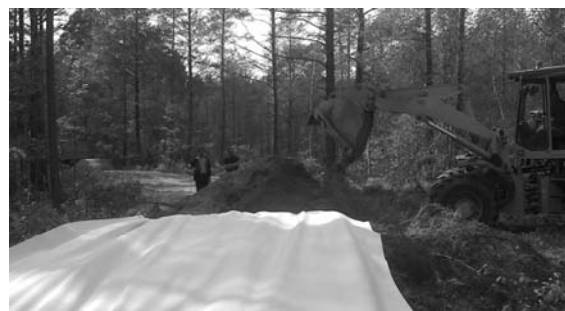
Рис. 3. Отсыпка грунта на полотно дороги
