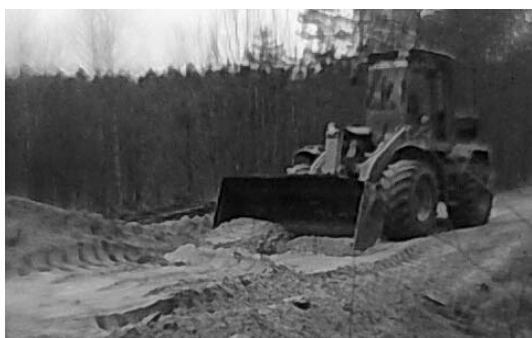
Рис. 4. Разравнивание грунта погрузчиком
