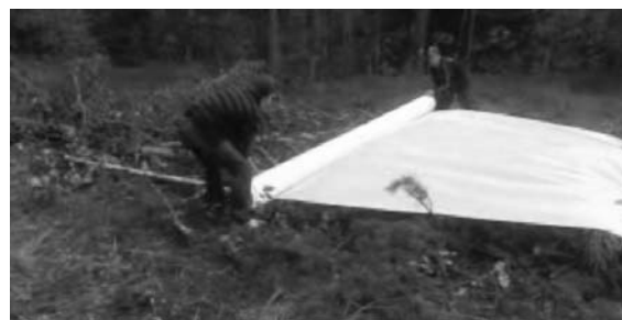
Рис. 2. Укладка порубочных остатков на спланированное основание и раскатка нетканого синтетического материала
